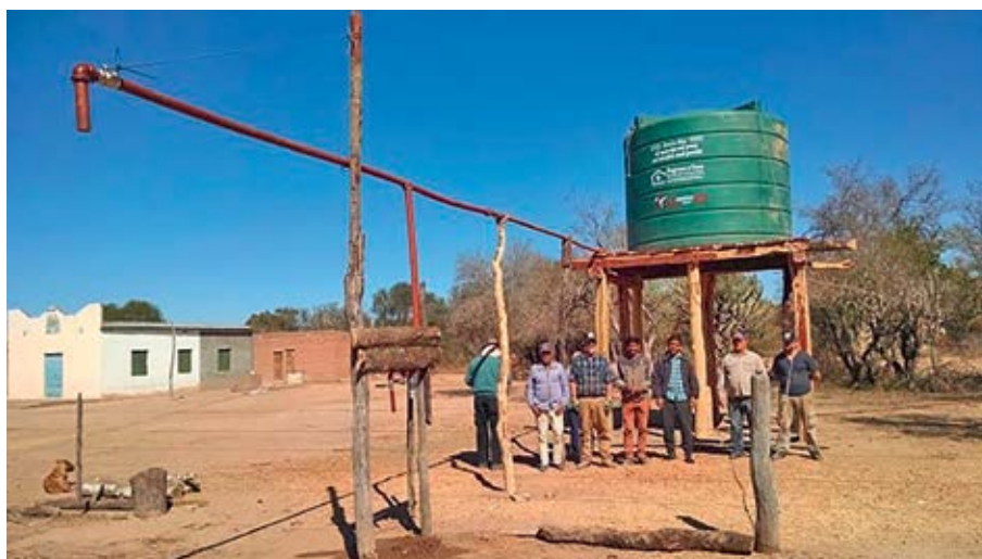
Wassertank in Miraflores auf einer Holzkonstruktion
