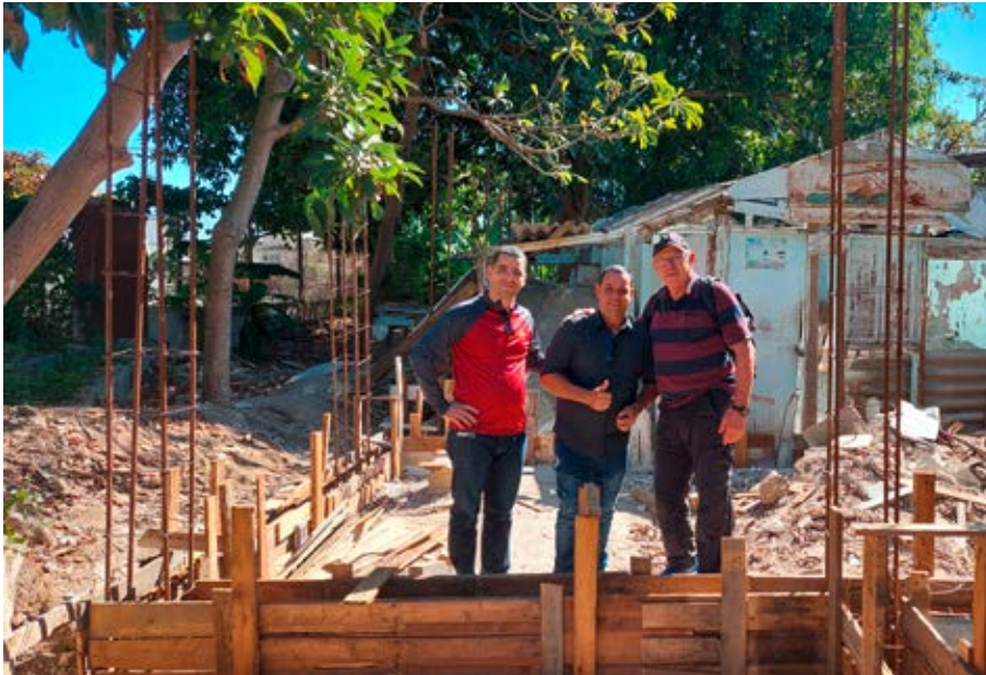
Kapellenbau der Gemeinde La Timba
